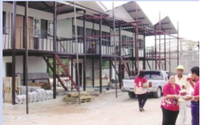
Les maisons à Baan Nai Rai en construction
