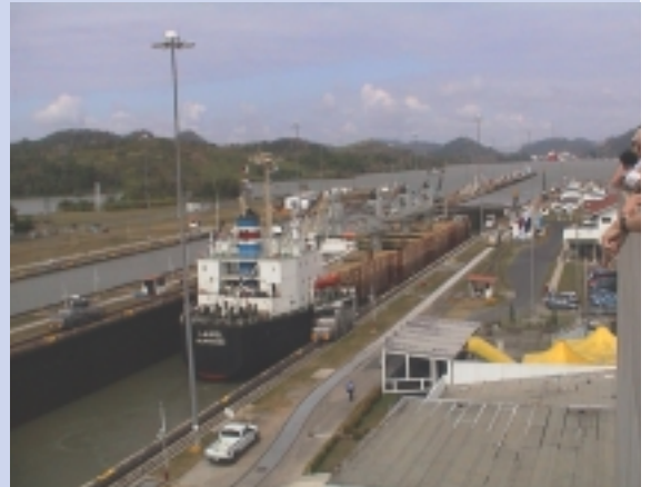
Les dimensions maximales des bateaux transitant par le canal sont de 34,5 m de large et 305 m de long. Ces navires sont appelés panamax.
